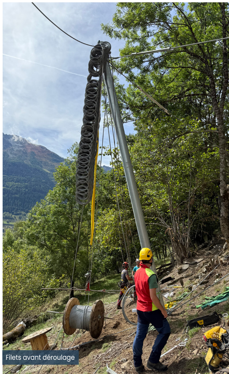
Installation des filets de protection
