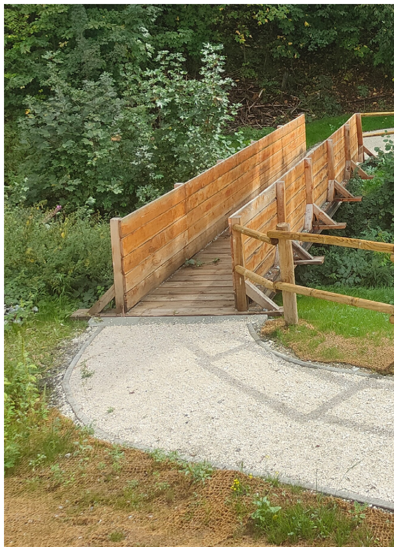
Dégâts engendrés par la tempête de novembre 2024
