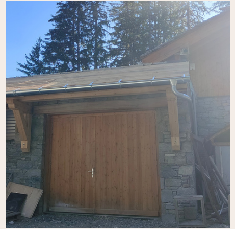
Toit du local compresseur de Planbois
