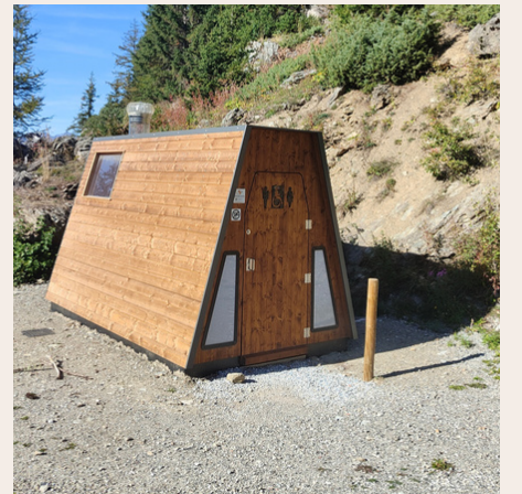
Toilette sèche parking Echaillon
