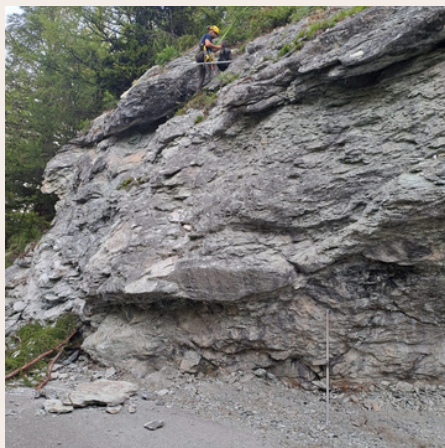
Purge rocher avant le Franier
