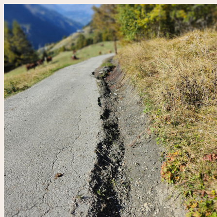
Cunette route d'accès Nancroix
