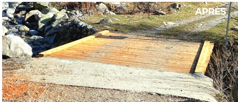
Rénovation pont sur le chemin de la conduite
